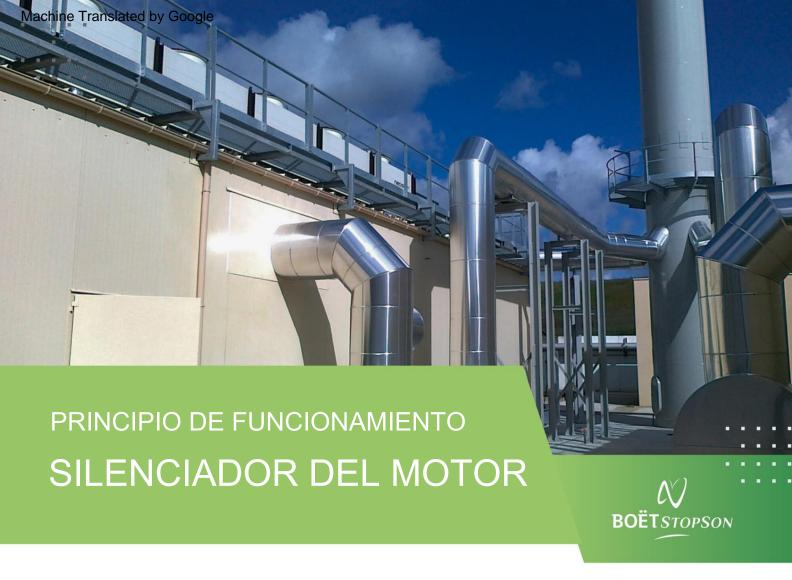
Los silenciadores de motor son dispositivos integrados en la línea de escape de los motores de combustión interna. Están diseñados para reducir el ruido emitido por el motor teniendo las mínimas pérdidas de presión. Se trata de los llamados silenciadores pasivos. A diferencia de los silenciadores activos, que utilizan componentes eléctricos y electrónicos para reducir el ruido mediante interferencias de ondas, los silenciadores pasivos son dispositivos puramente mecánicos.
